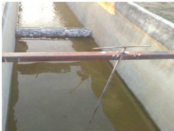
รูปที่ 8 เครื่องวัดระดับน้ำ
