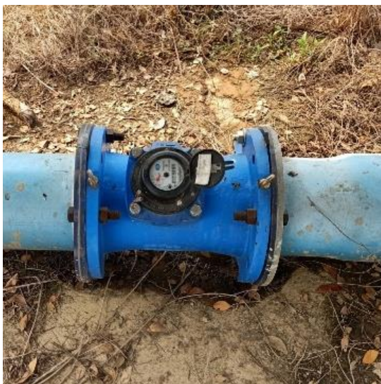
รูปผนวกที่ ก3 มิเตอร์วัดอัตราการไหล
