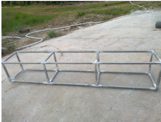
รูปที่ 7 ก่อสร้างข่ายเกเบียน
