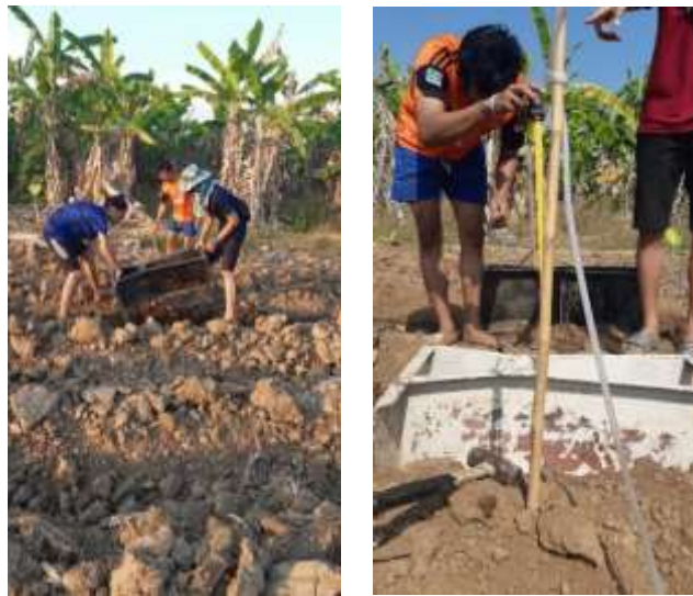
ภาพที่ 3.5 ติดตั้งรางวัดน้ำแบบไม่มีคอ (Cut-throat Flume) ขนาด 10x90 ซม.
