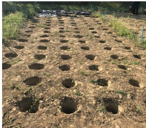
รูปที่ 3.1 ขุดหลุม
