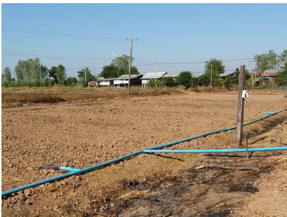
ภาพผนวกที่ จ2 ระบบท่อส่งน้ำและมิเตอร์วัดน้ำในการเพาะปลูกข้าว ฤดูนาปรัง ปี พ.ศ. 2560
