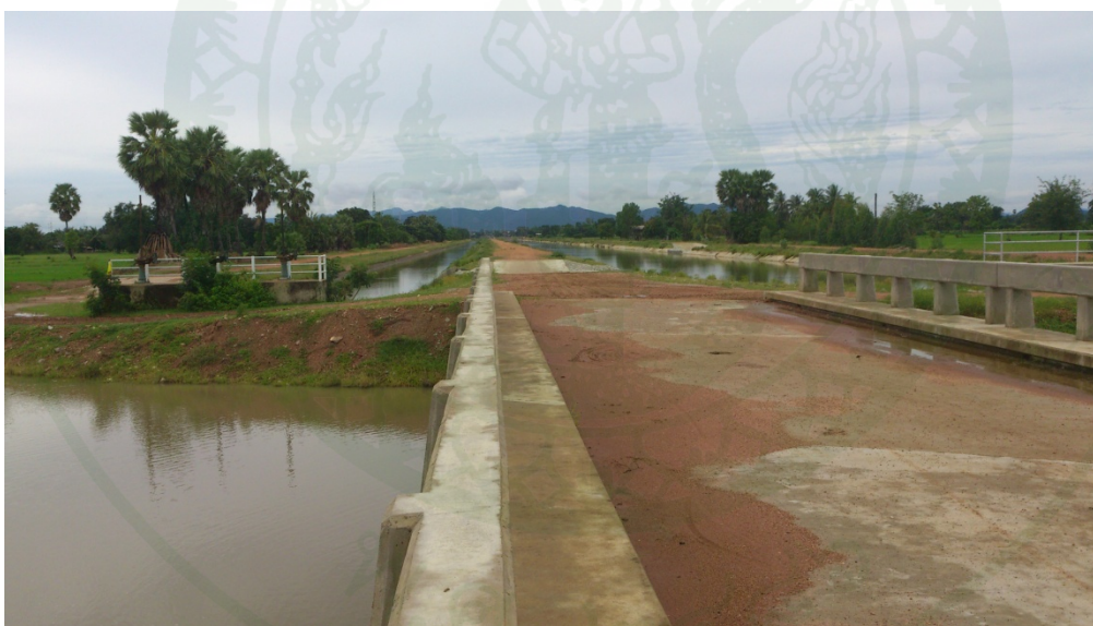
ภาพผนวกที่ ค3 คลองส่งน้ำลอดผ่านทางน้ำธรรมชาติ
