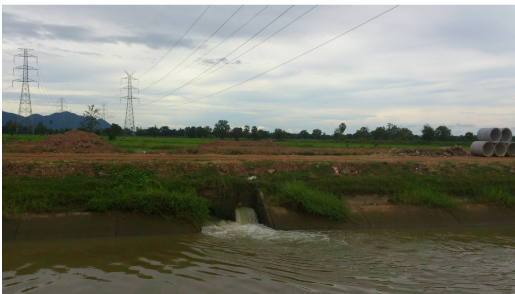
ภาพผนวกที่ ค2 ลักษณะการระบายน้ำลงคลองส่งน้ำ 1L
