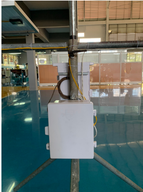
รูปที่ 14 ติดตั้งตู้บรรจุแบตเตอรี่
