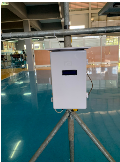
รูปที่ 12 ติดตั้งตู้บรรจุแผงวงจร
