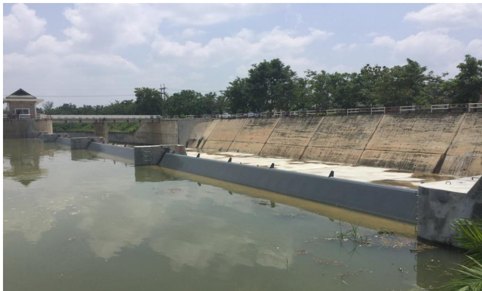
รูปที่ 3 ฝายพับได้ Type III-A บนสันของ Spill Way ของอ่างเก็บน้ำประแสร์ อ.วังจันทร์ จ.ระยอง
