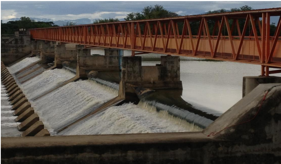
รูปที่ 4 ฝายยาง ขนาดสูง 1.50 เมตรยาว 20.00 เมตร จำนวน 5 ช่องบนสันฝายคอนกรีตของฝายหนองสลีก อ.ป่าซาง จ.ลำพูน ที่ชำรุดเสียหาย
