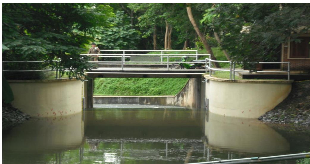
รูปที่ 1 ฝายพับได้ Type I-A บนสัน Spill way ของอ่างเก็บน้ำแม่จอกหลวง อ.แม่ริม จ.เชียงใหม่
