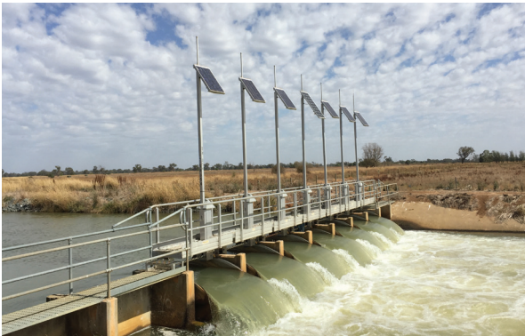
c. ประตูระบายน้ำที่มีสะพานน้ำเปิด-ปิดหลายช่องที่เขตชลประทานมาคาลิสเตอร์ (Macalister) (แหล่งข้อมูล: เซาท์เทิร์น รูเรียล วอเตอร์ (Southern Rural Water))
