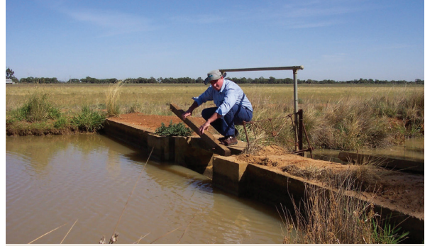
b. ใช้มือปรับระดับน้ำที่ประตูระบายน้ำปลายคลองโดยลดแท่งไม้ลง (แหล่งข้อมูล: รัฐวิกตอเรีย)
