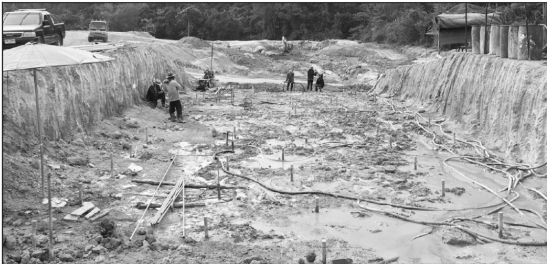
รูปที่ 4 พื้นที่ศึกษาและทดลอง บริเวณ กม.0+453 ถึง กม.0+485 ประกอบด้วยหลุมเจาะ-อัดฉีด จำนวน 5 แถว
