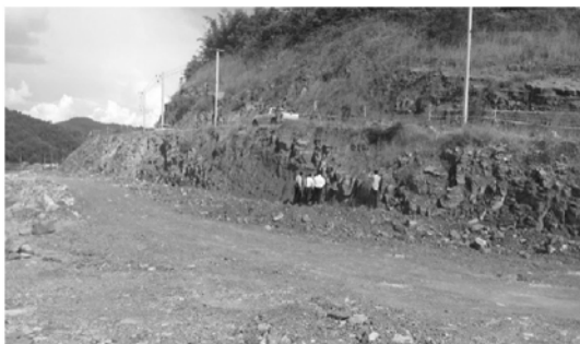
รูปที่ 7 แสดงสภาพของหินทรายแป้ง (Siltstone) ที่มีการผุพังแตกตัวในสภาพแห้ง (slaking)
