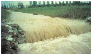
สิ่งก่อสร้างชะลอความเร็วของน้ำในทางระบายน้ำ
