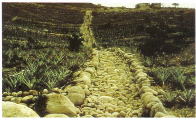
ทางระบายน้ำที่สร้างด้วยหิน
