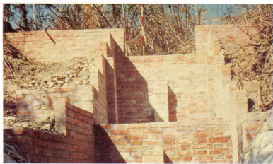
ทางระบายน้ำที่สร้างด้วยอิฐ
