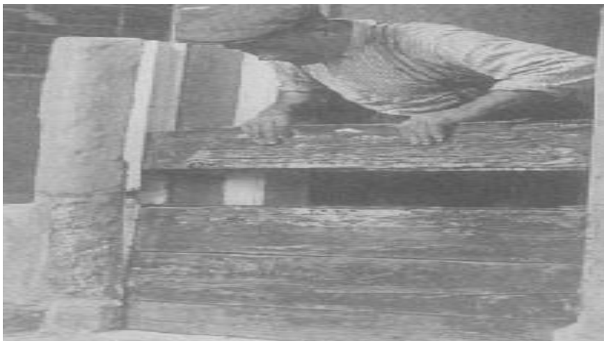
รูปที่ 6-9 การวางท่อนกั้นน้ำที่ประตูในประเทศเนเธอร์แลนด์
