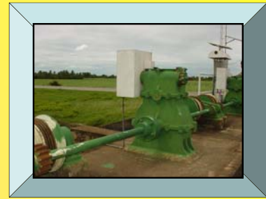
ติดตั้ง DC Gear Motor และ Solar cell ที่ km. 3 + 650 คลอง 5L-2L
