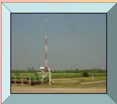
ติดตั้ง robogate km.9+813 5L-2L
