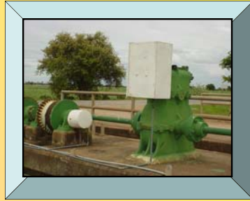
ติดตั้ง DC Gear Motor และ Solar cell ที่ km. 3 + 650 คลอง 5L-2L
