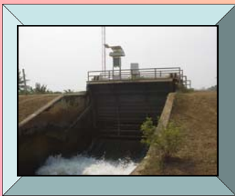
ติดตั้ง DC Gear Motor และ Solar cell ที่ km. 9 + 813 และ km. 20 + 300 คลอง 5L-2L
