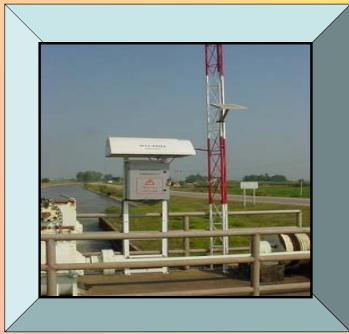
ติดตั้ง robogate km.3+650 5L-2L
