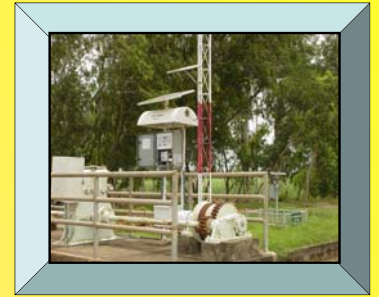
ติดตั้ง robogate km.20+300 5L-2L
