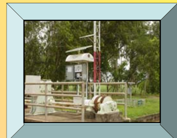
ติดตั้ง DC Gear Motor และ Solar cell ที่ km. 9 + 813 และ km. 20 + 300 คลอง 5L-2L
