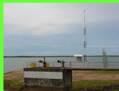
ระบบโทรมาตร อ่างเก็บน้ำห้วยถ้ำเขื่อนราชนานี
