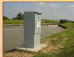
ติดตั้งตู้บ่อน้ำ
