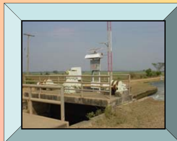
ติดตั้ง DC Gear Motor และ Solar cell ที่ km. 9 + 813 และ km. 20 + 300 คลอง 5L-2L
