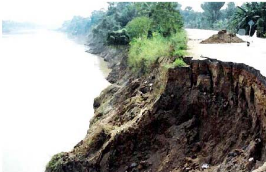
รูปที่ 3 ตัวอย่างการพังทลายเนื่องจากกัดเซาะของตลิ่ง
