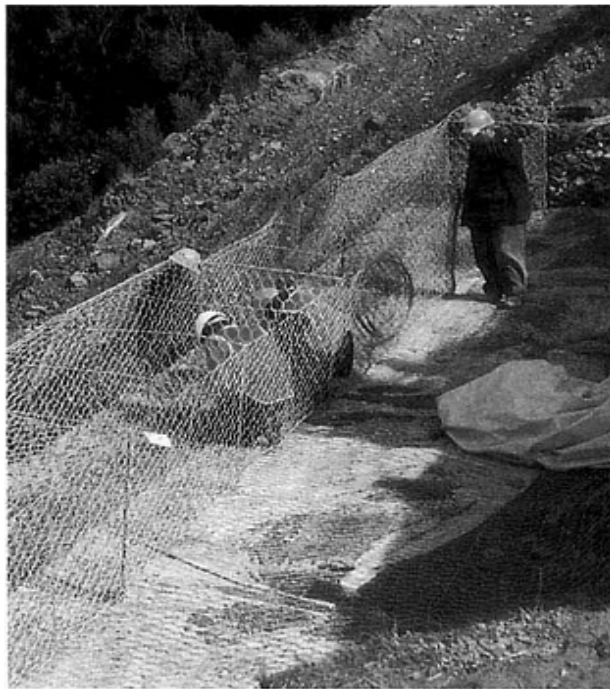
รูปที่ 22 การเชื่อมต่อกล่อง Gabion เข้าด้วยกัน
