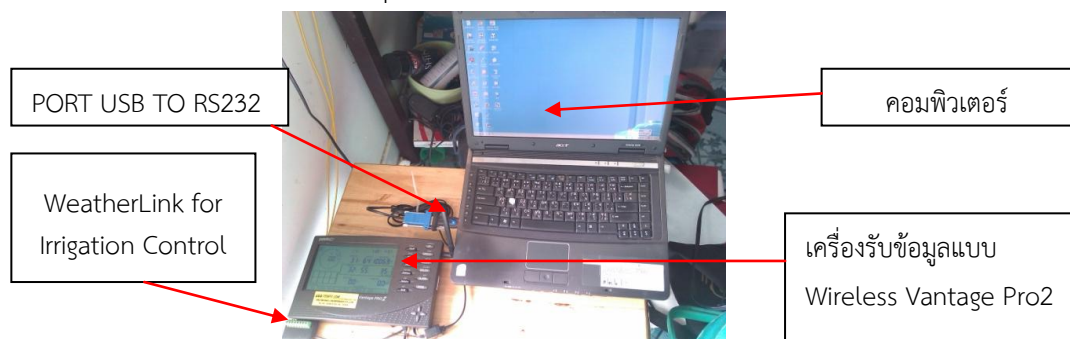
ภาพที่ 4-21 ทำการติดตั้งอุปกรณ์ในส่วนที่ 2
