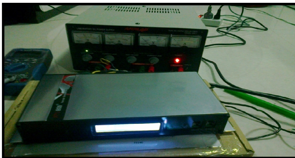
ภาพที่ 31 การต่อเครื่องวัดระดับน้ำกับเครื่อง RTU800
