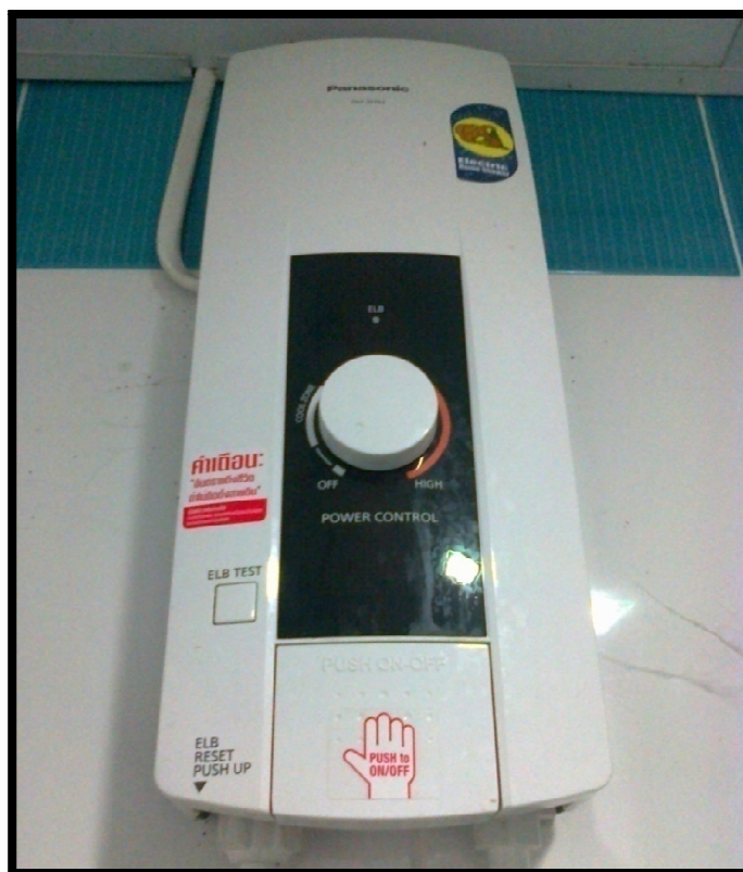
ภาพที่ 50 เครื่องทำน้ำอุ่นที่ใช้ในการปรับอุณหภูมิน้ำ
