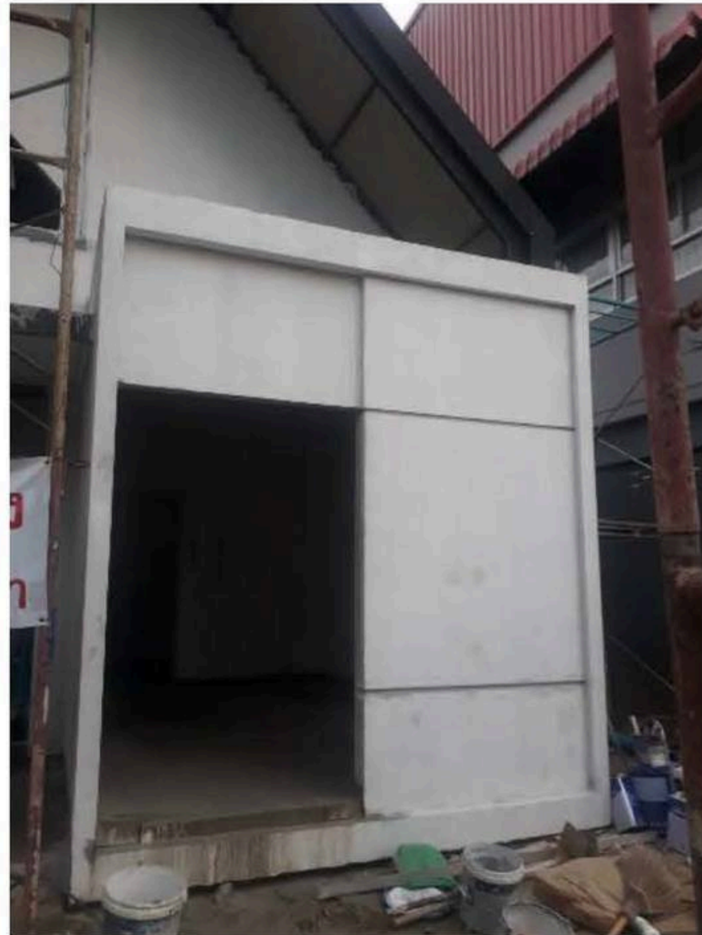
รูปที่ 9 พื้นผิวของแผ่นปะการังหลังฉาบเรียบร้อยและเตรียมติดตั้งหน้าต่างโดยไม่ใช่คานทับหลัง
