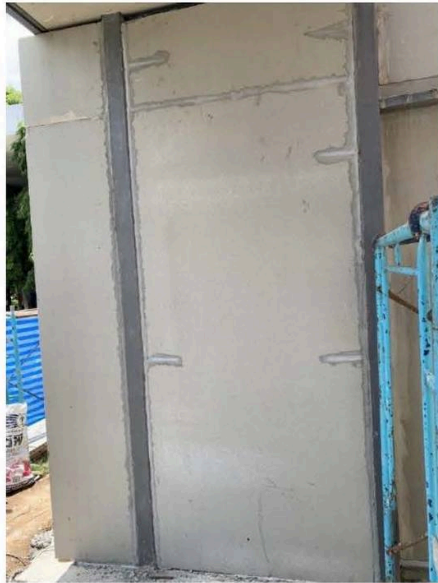
รูปที่ 7 การยึดแผ่นปะการังกับเหล็กหนวดกุ้ง
