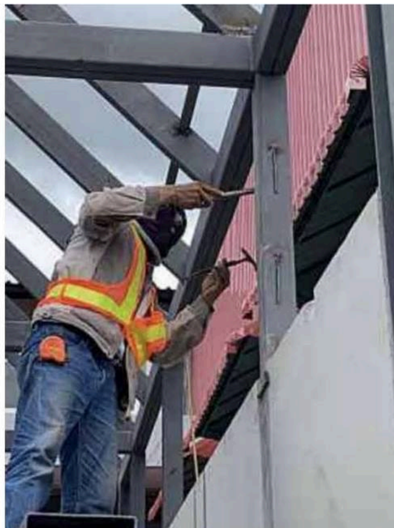
รูปที่ 4 ติดตั้งเหล็กหนวดกุ้ง
