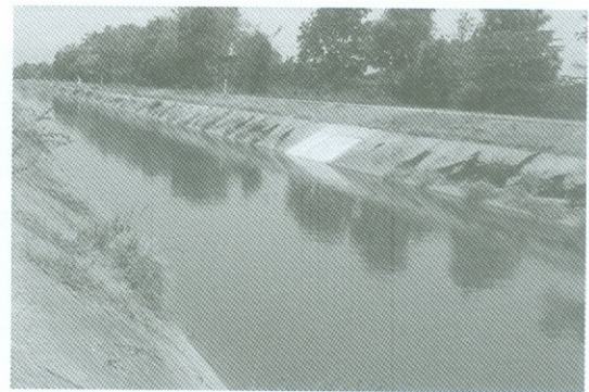
๔) ผ้าใบคอนกรีตหลังจากการติดตั้งแล้วมูมเกล
