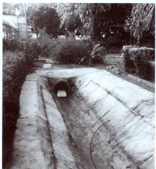
๔) คูระบายน้ำหลังจากการลอกตะกอนออก
