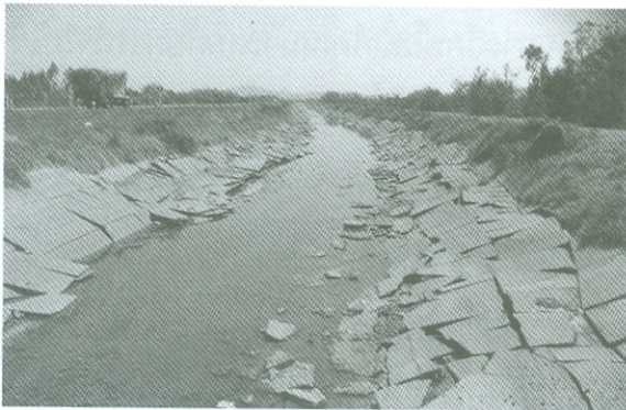
a) การพังทลายของลาดคลองชลประทาน เนื่องจากดินยุบตัวทั้งสาย
