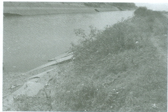
b) การพังทลายของลาดคลองชลประทาน เนื่องจากดินยุบตัวบางส่วน
