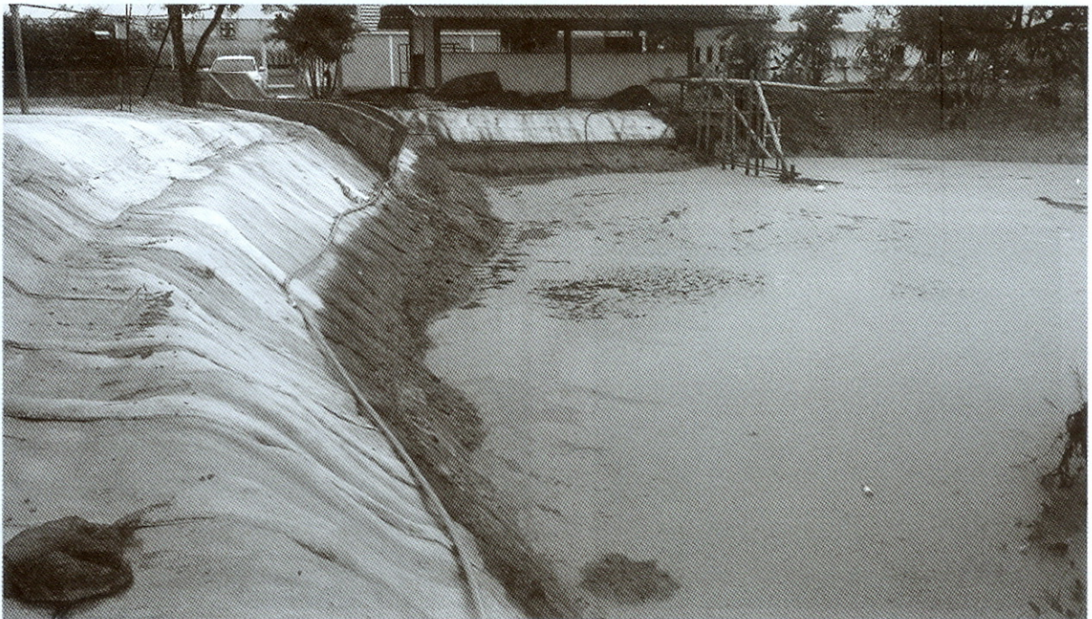
รูปที่ 6 การนำผ้าใบคอนกรีตมาใช้ทาดสระเก็บน้ำ
