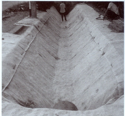
๒) การติดตั้งผ้าใบเพื่อปรับปรุงคูระบายน้ำ
