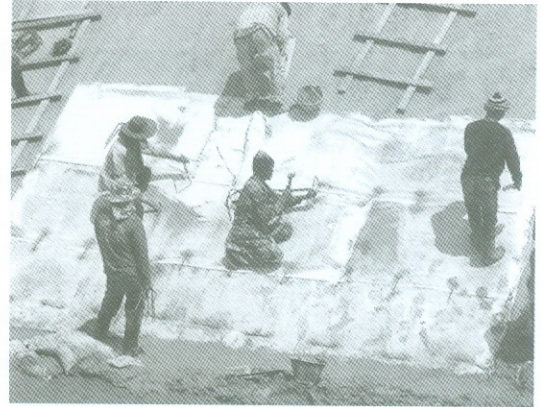
๒) ผ้าใบคอนกรีตขณะกำลังติดตั้ง
