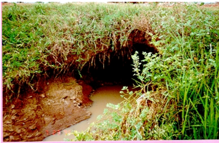
รูปที่ 12 ความเสียหายของคันดิน ประเภทที่ 6 การกัดเซาะเป็นรูทะลุผ่านคันคลอง ด้านนอก
