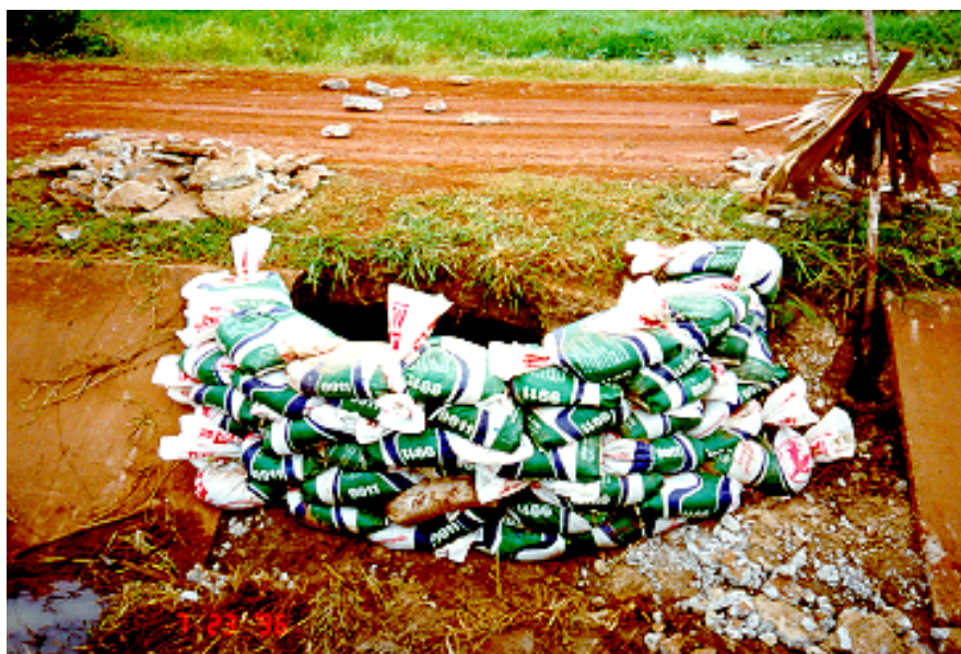
รูปที่ 11 ความเสียหายของคันดิน ประเภทที่ 6 การกัดเซาะเป็นรูทะลุผ่านคันคลองด้านใน
