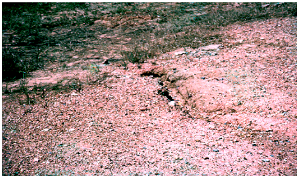
รูปที่ 9 ความเสียหายของคันดิน ประเภทที่ 3 การกัดเซาะเป็นรูปตัว V
