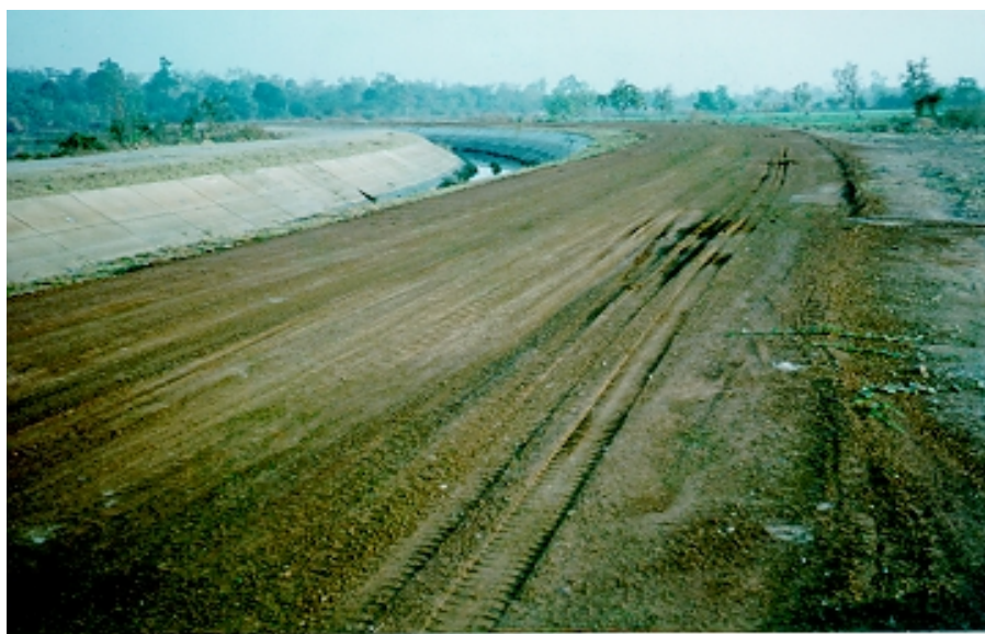
รูปที่ 10 ความเสียหายของคันดิน ประเภทที่ 4 คันดินทรุดตัว
