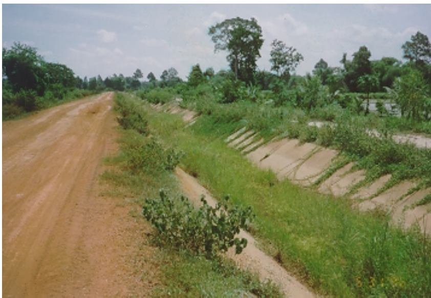
รูปที่ 13 ตะกอนตกจมที่ต้องขุดลอก
