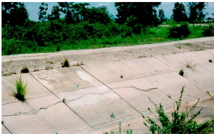
รูปที่ 16 ความเสียหายของคอนกรีตคาด ประเภทที่ 2 แตกร้าว
