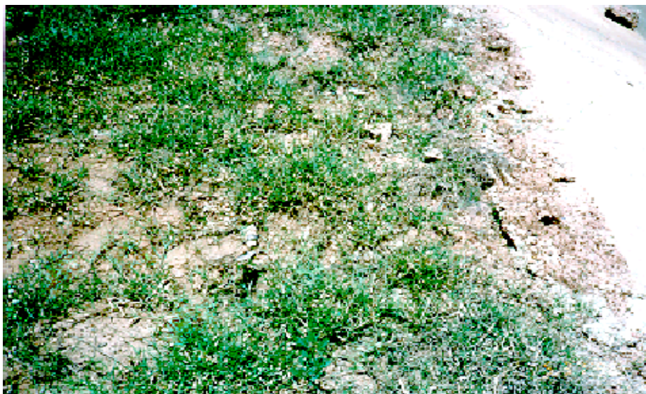
รูปที่ 4 ความเสียหายของคันดิน ประเภทที่ 1 การกัดเซาะเป็นรูโพรงบริเวณขานคลอ ระยะเริ่มต้น
