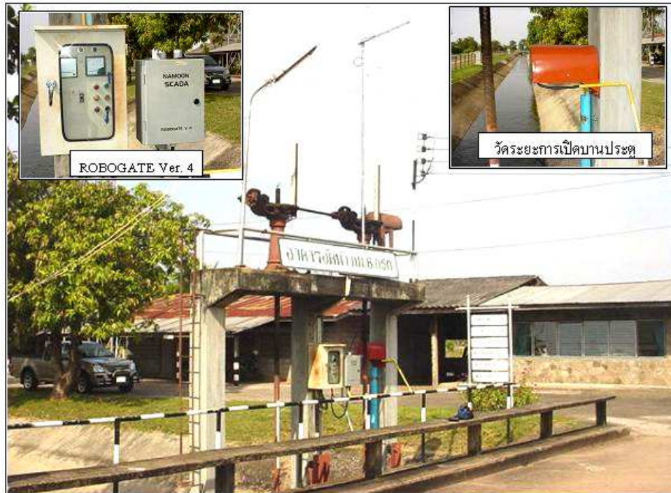
รูปที่ 3 ประตูนัดควบคุมประตูระบายน้ำหน้างานส่งน้ำและบำรุงรักษาที่ 2
