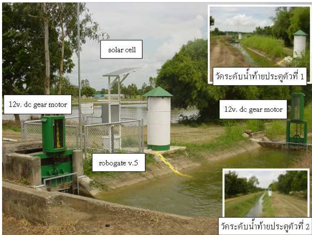
รูปที่ 7 Robogate คลองส่งน้ำสายใหญ่ กม. 1 + 150 และปากคลองซอย กม. 0 + 000
