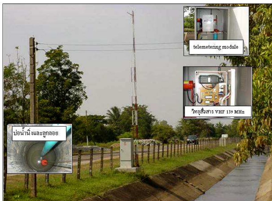
รูปที่ 2.1 สถานีโทรมาตรท้ายประตูระบายน้ำหน้างานส่งน้ำและบำรุงรักษาที่ 2
