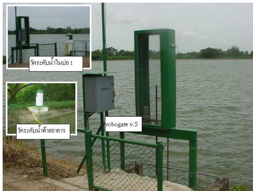
รูปที่ 6 Robogate v.5 ปากคลองส่งน้ำสายใหญ่ กม. 0 + 000
