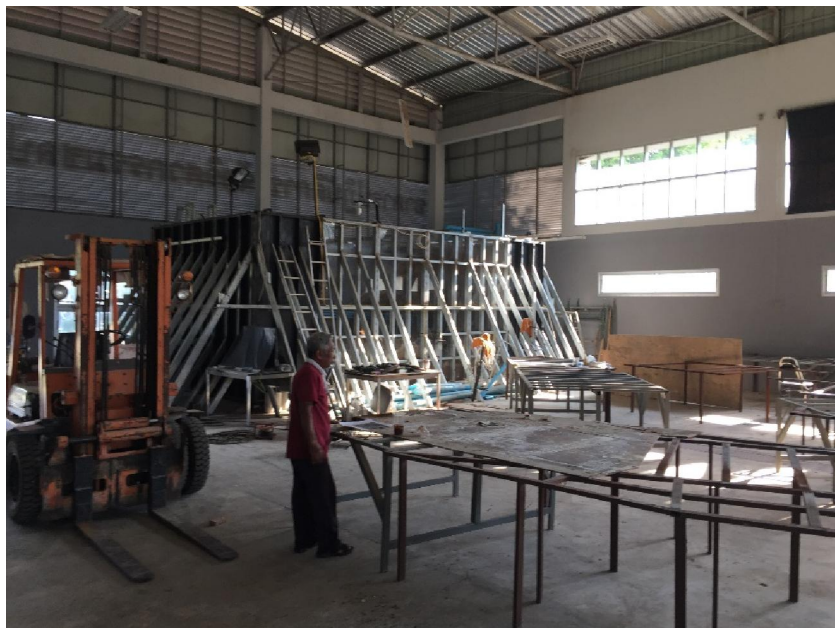
ภาพที่ 2.6 การดำเนินงานก่อสร้างโครงสร้างฐานรองยกระดับแบบจำลองอ่างเก็บน้ำแก่งกระจาน
