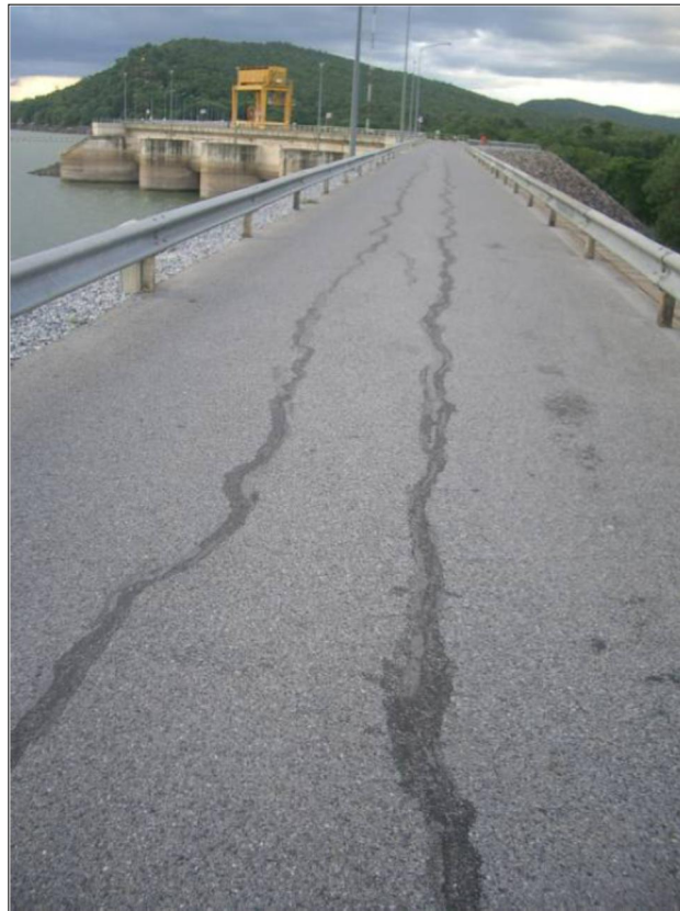
รูปที่ ง.5.2-6 รอยแตกขนานกับแนวแกนเขื่อน
