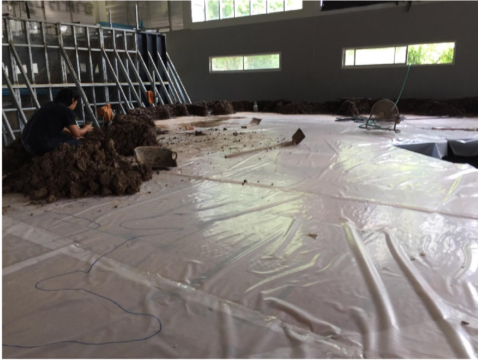
ภาพที่ 2.7 เริ่มสร้างคันดินตามแนวสันอ่างเก็บน้ำ
