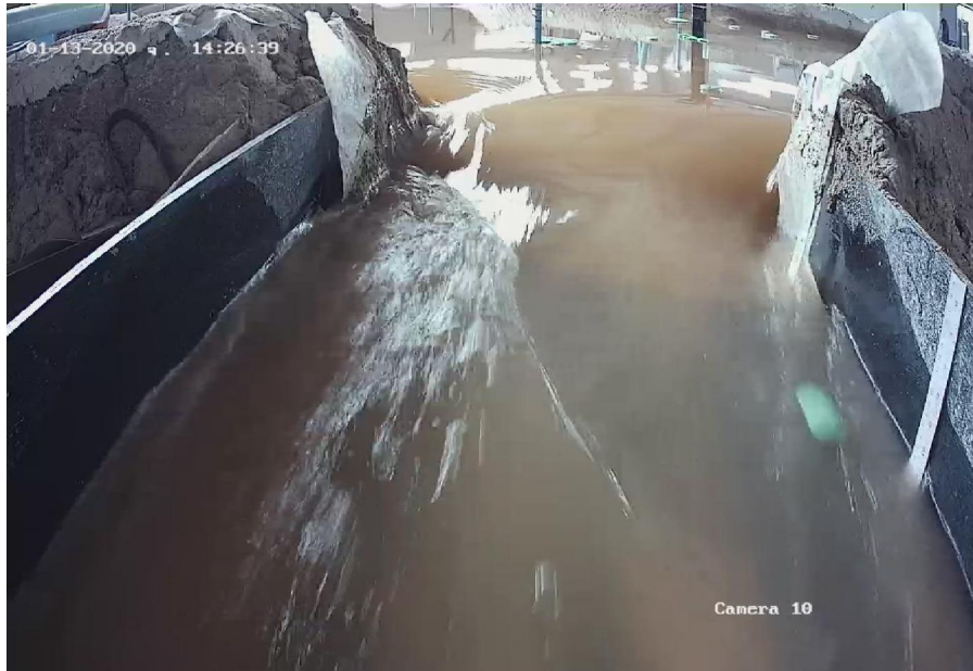
ภาพที่ ข1.7.แบบจำลองเขื่อนแก่งกระจานในปริมาณน้ำในอ่างเก็บน้ำเริ่มลดระดับลง
