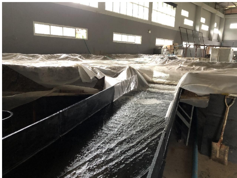
ภาพที่ 2.12 การรองพื้นอ่างด้วยแผ่นพลาสติกและการทดสอบปริมาตรน้ำในอ่าง
