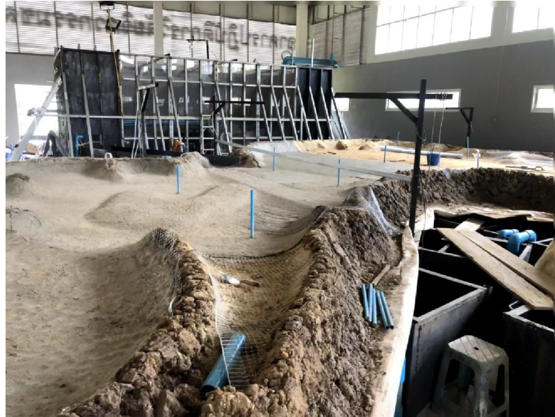
ภาพที่ 2.13 การคาดคอนกรีตที่พื้นอ่างเก็บน้ำจำลอง
