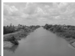
Kênh Xuân Hòa Trạm bơm tưới nước
