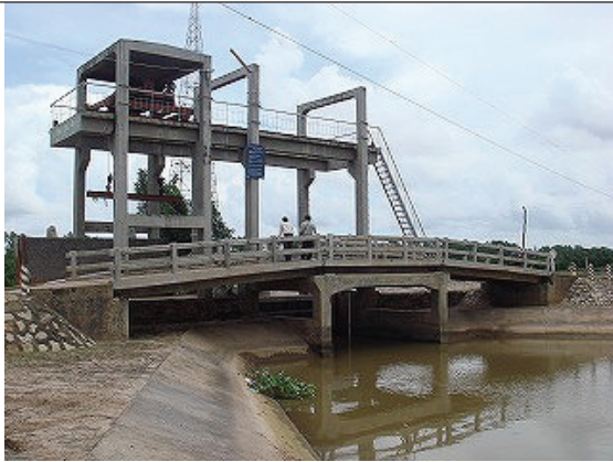
Long Hai sluice
