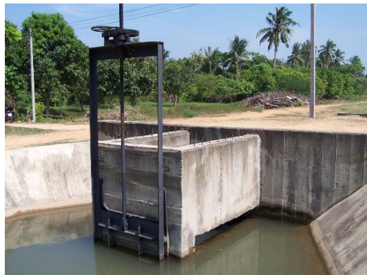
Mixed Regulator แบบความกว้างคลองจำกัด Operate แบบ Mixed Mode (น้ำไหลตลอดได้บานและไหลล้นฝาย) (โครงการส่งน้ำและบำรุงรักษาเพชรบุรี)
