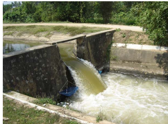
Check Drop แบบช่องเปิดเป็นรูปสี่เหลี่ยมผืนผ้า (โครงการส่งน้ำ และบำรุงรักษาเพชรบุรี)
