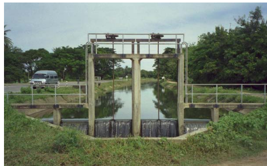
Mixed Regulator ที่ Operate ในโมดของฝายน้ำล้น (โครงการส่งน้ำและบำรุงรักษาเพชรบุรี)
