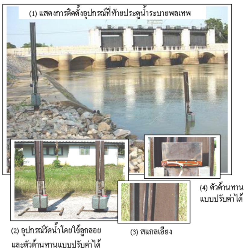
รูปที่ 4.1 อุปกรณ์วัดระดับน้ำแบบลูกลอยโดยใช้ตัวต้านทานแบบปรับค่าได้
