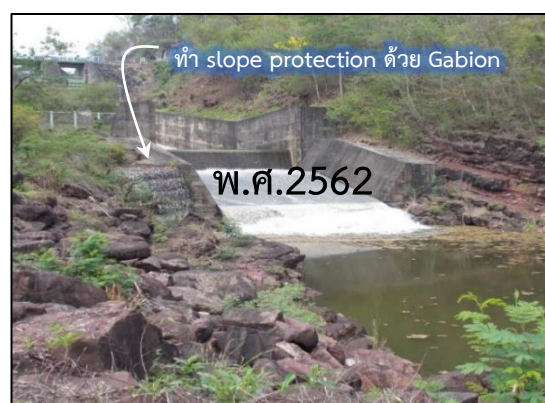
รูปที่ 4.19.1-6 การกัดเซาะลาดตลิ่งท้ายอาคารระบายน้ำล้นเขื่อนห้วยกุ่ม
