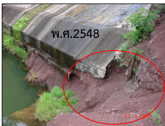
รูปที่ 4.19.1-5 การกัดเซาะ (Scouring) ได้แผ่นกันกระแทกและลาดตลิ่งท้ายอาคารระบายน้ำล้นเขื่อนจุฬาภรณ์
