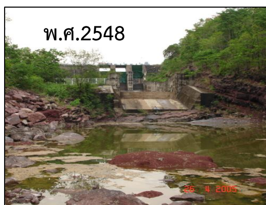
รูปที่ 4.19.1-6 การกัดเซาะลาดตลิ่งท้ายอาคารระบายน้ำล้นเขื่อนห้วยกุ่ม
