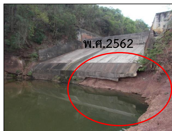
รูปที่ 4.19.1-5 การกัดเซาะ (Scouring) ได้แผ่นกันกระแทกและลาดตลิ่งท้ายอาคารระบายน้ำล้นเขื่อนจุฬาภรณ์
