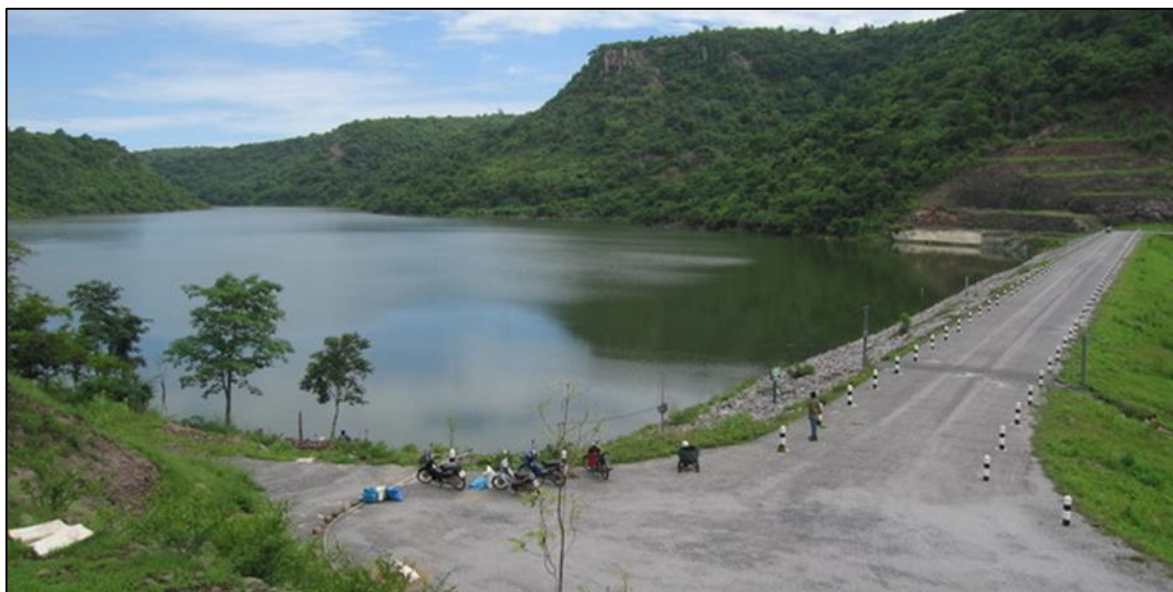
ภาพที่ 2.2-11 ภาพอ่างเก็บน้ำห้วยหิน
