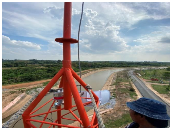
รูปที่ 19 อุปกรณ์รับ – ส่งสัญญาณแบบ Point to Point (ระยะทางไม่เกิน 7 กิโลเมตร)
