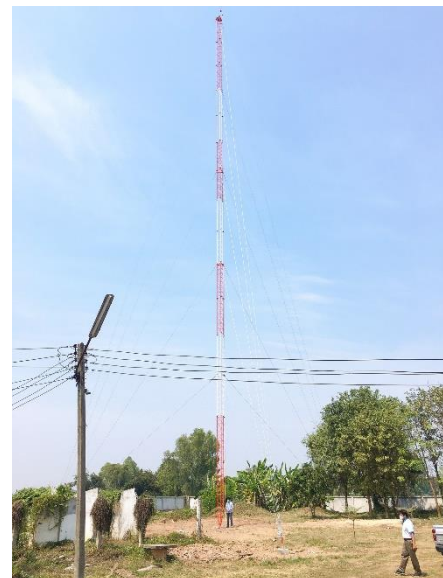
รูปที่ 16 เสาอากาศวิทยุชนิดโครงสร้างสามเหลี่ยม แบบ Guyed-Support ความสูง 150 ฟุต
