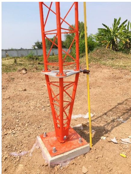
รูปที่ 16 เสาอากาศวิทยุชนิดโครงสร้างสามเหลี่ยม แบบ Guyed-Support ความสูง 150 ฟุต
