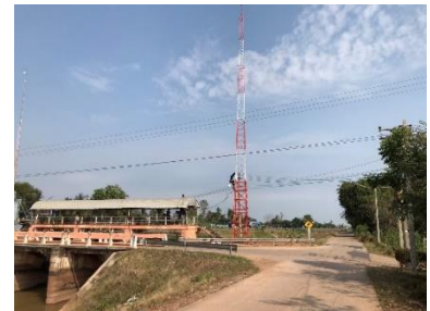
รูปที่ 17 เสาอากาศโครงสร้างเหล็กสี่เหลี่ยมแบบไม่มีสายยึดโยง ความสูง 24 เมตร
