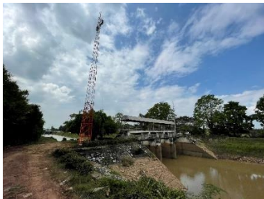
รูปที่ 17 เสาอากาศโครงสร้างเหล็กสี่เหลี่ยมแบบไม่มีสายยึดโยง ความสูง 24 เมตร
