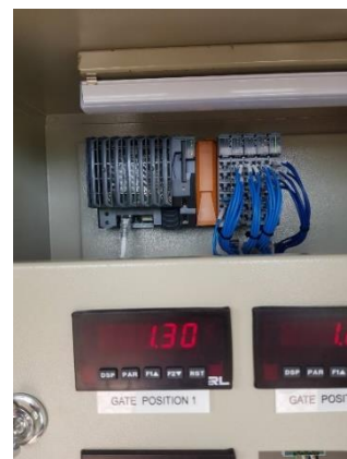
รูปที่ 20 อุปกรณ์ตรวจวัดระยะไกล (Remote Terminal Unit, RTU)
