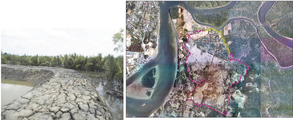
รูปที่ 6 คันดินกันน้ำเค็มที่ก่อสร้างในปี พ.ศ. 2553 เพื่อป้องกันพื้นที่นาในหมู่ที่ 1 บ้านเกาะกลาง
