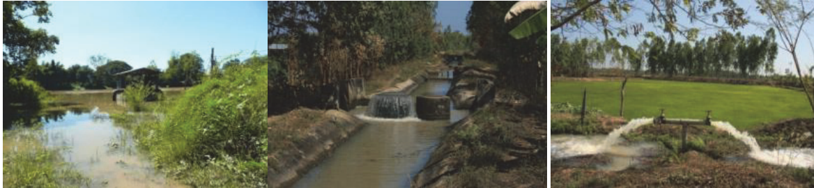
รูปที่ 2 สถานีสูบน้ำด้วยไฟฟ้าริมลำน้ำปาว ระบบคลองซอยและท่อใต้ดินที่เริ่มดำเนินการในปัจจุบัน
