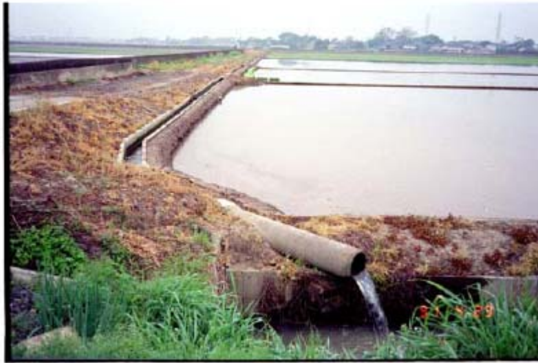
รูปที่ 24 ตัวอย่างสภาพการส่งน้ำที่มากเกินไปในคลองแยกซอย
