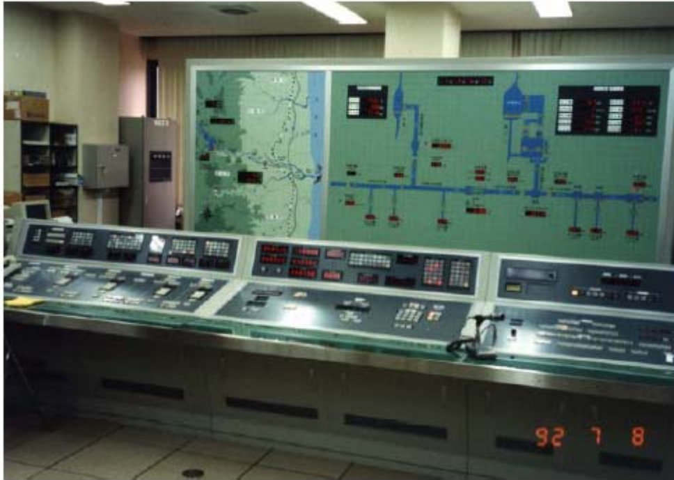
รูปที่ 48 ห้องควบคุมระบบควบคุมและติดตามระยะไกล
