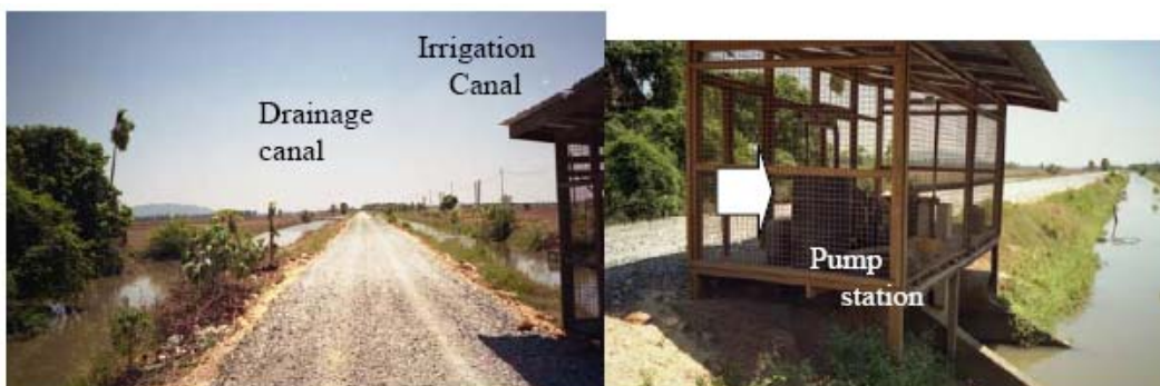
รูปที่ 51 คลองส่งน้ำ คลองระบายน้ำ และสถานีสูบน้ำที่ใช้ในการนำน้ำกลับมาใช้
