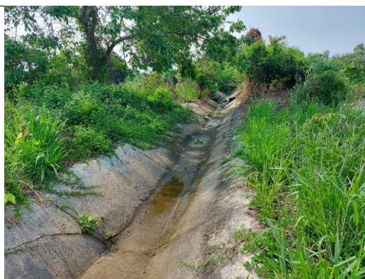
สถานีสูบน้ำด้วยไฟฟ้า อ.ชะอำ จ.เพชรบุรี 13 มี.ค. 65
