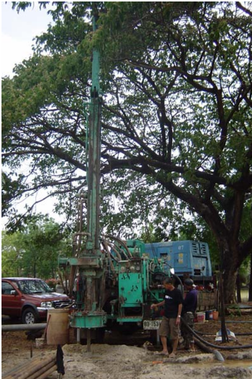
(ก) แสดงเครื่องเจาะแบบคัตโรตและเครื่องปั๊มลม
