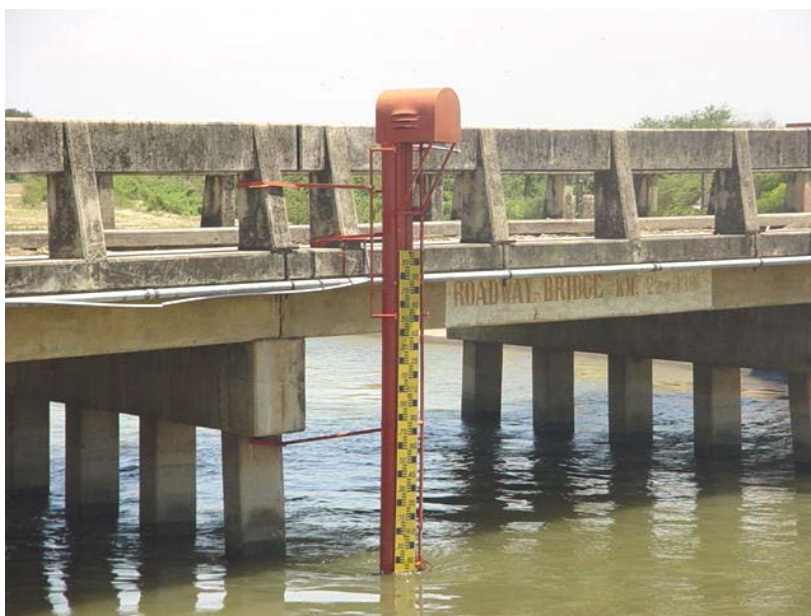
รูปที่ 31 ตรวจวัดระดับน้ำท้ายประตูระบายน้ำ
