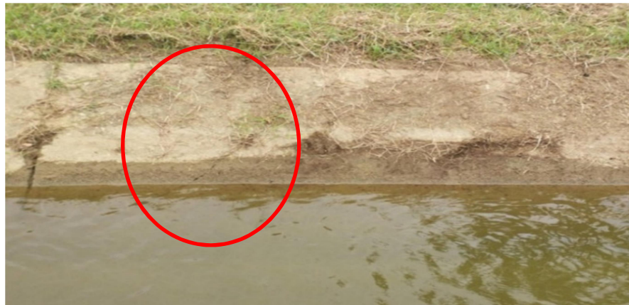
ภาพที่ 4-4 การเกิดรอยแตกตามขวางของคลองส่งน้ำ 1L-1
