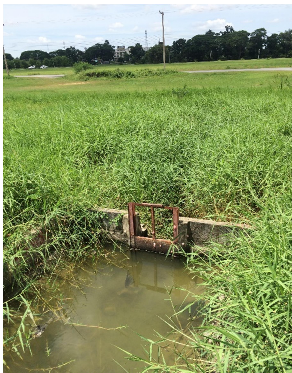
ภาพที่ 4-18 อาคารประตูระบายน้ำปลายคลองของคลอง 1L-1
