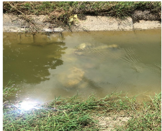
ภาพที่ 4-7 การเกิดตะกอนและขยะในคลองส่งน้ำ 1L-1
