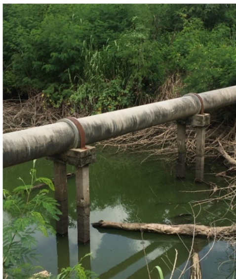
(ค) ท่อส่งน้ำและตอม่อรับท่อ
