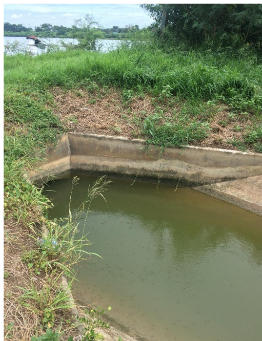
(ข) ท่อลอดถนนด้านท้ายน้ำ
