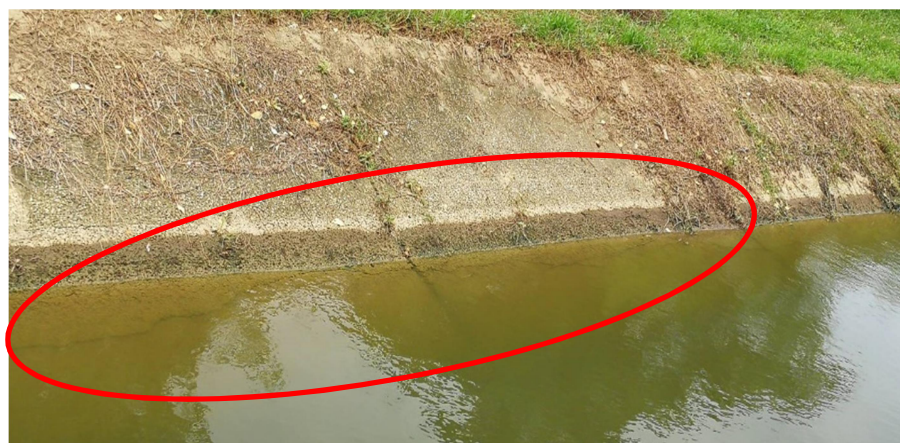
ภาพที่ 4-1 การเกิดรอยแตกตามยาวแบบต่อเนื่องของคลองส่งน้ำ 1L-1
