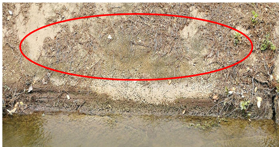
ภาพที่ 4-2 การเกิดรอยแตกตามยาวแบบไม่ต่อเนื่องของคลองส่งน้ำ 1L-1
