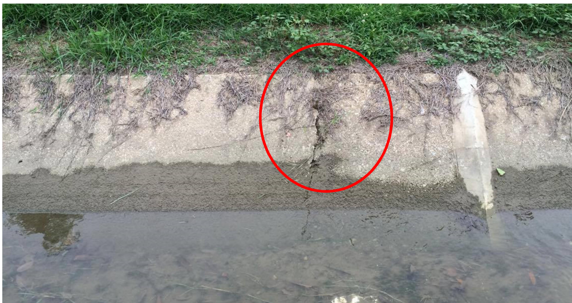
ภาพที่ 4-10 การเกิดรอยแตกตามขวางของคลองส่งน้ำ 2L-1L-1
