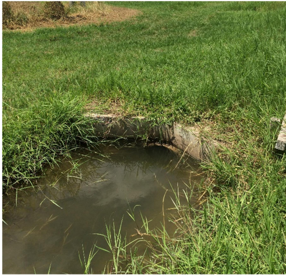
(ก) ท่อลอดถนนด้านเหนือน้ำ
