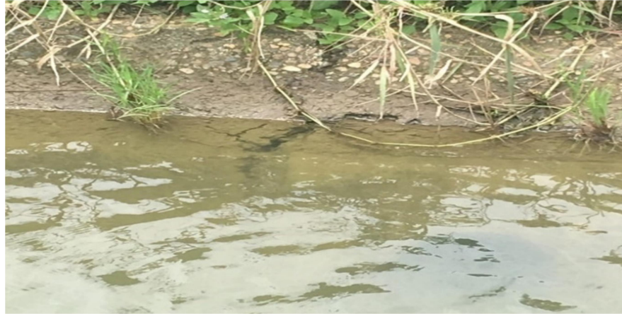
ภาพที่ 4-6 การพังทลายของคันคลองสู่คลองส่งน้ำ 1L-1
