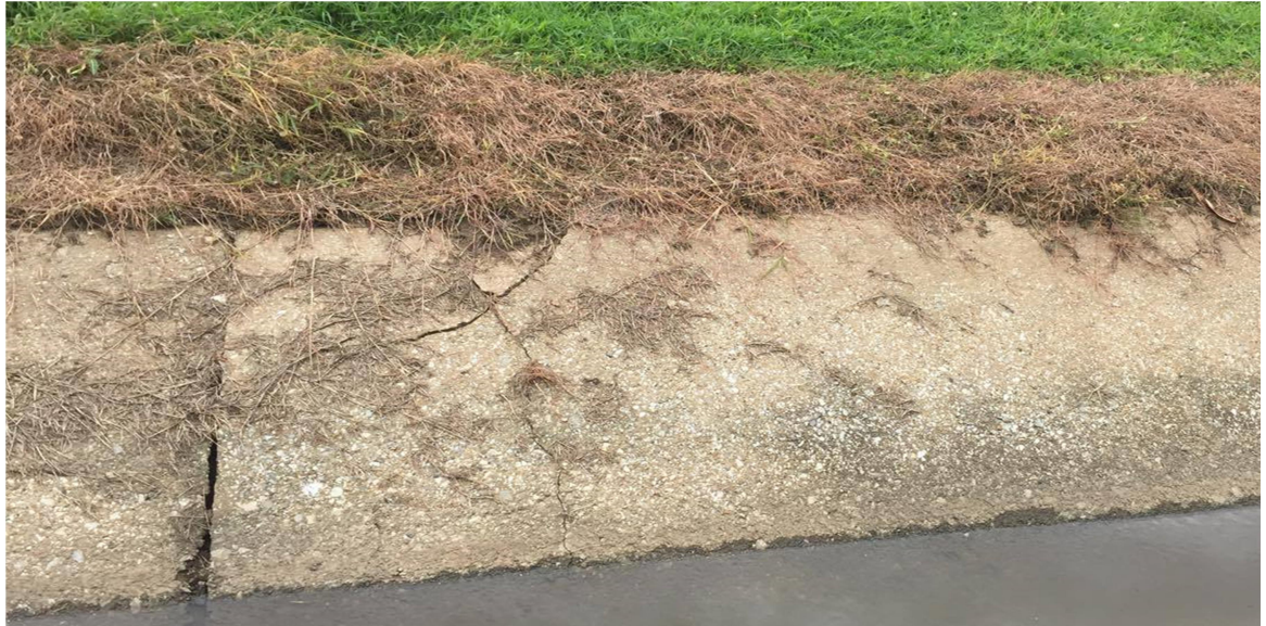
ภาพที่ 4-13 การพังทลายแบบโครงข่ายของคลองส่งน้ำ 2L-1L-1
