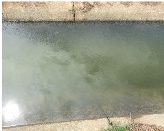
ภาพที่ 4-7 การเกิดตะกอนและขยะในคลองส่งน้ำ 1L-1
