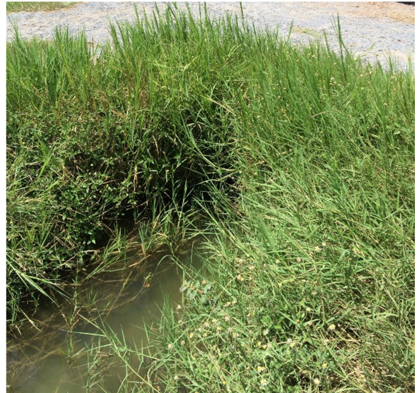
(ข) ท่อลอดถนนด้านท้ายน้ำ
