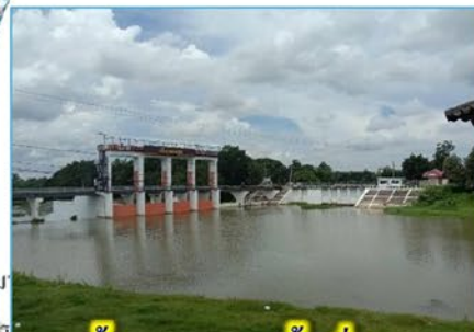
เขื่อนทดน้ำและระบายน้ำเขื่อนเพชร
