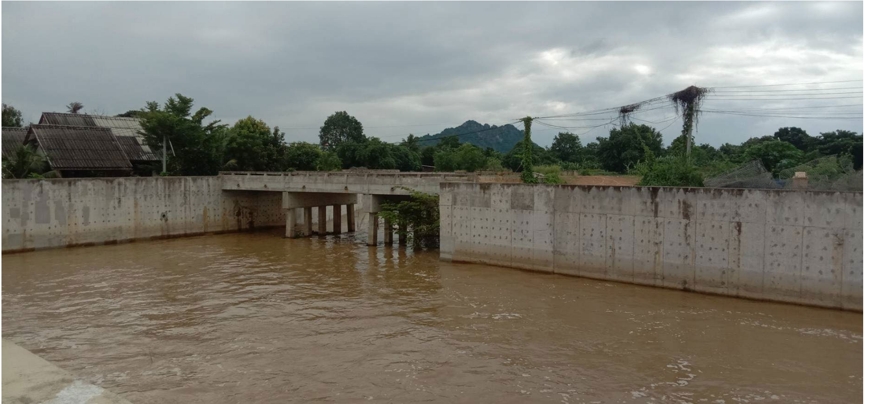
ปตร.ปลายคลอง 1 ขวา-สายใหญ่ 3 (ด้านท้าย)
